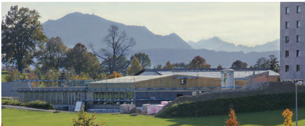
Blick auf den Anbau des Lehrtechnikums mit den neuen Produktions- und Arbeitsräumen
